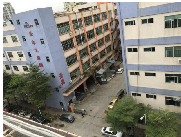
项目北面工业厂房
