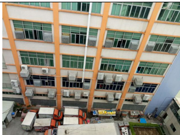
项目南侧工业厂房
